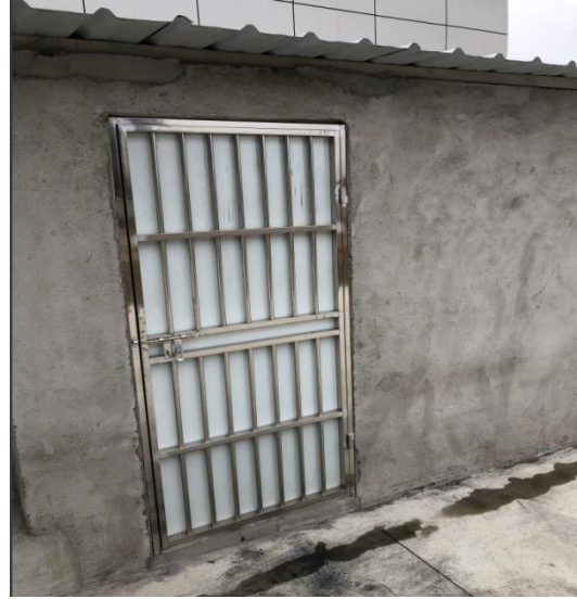
危险废物暂存间
