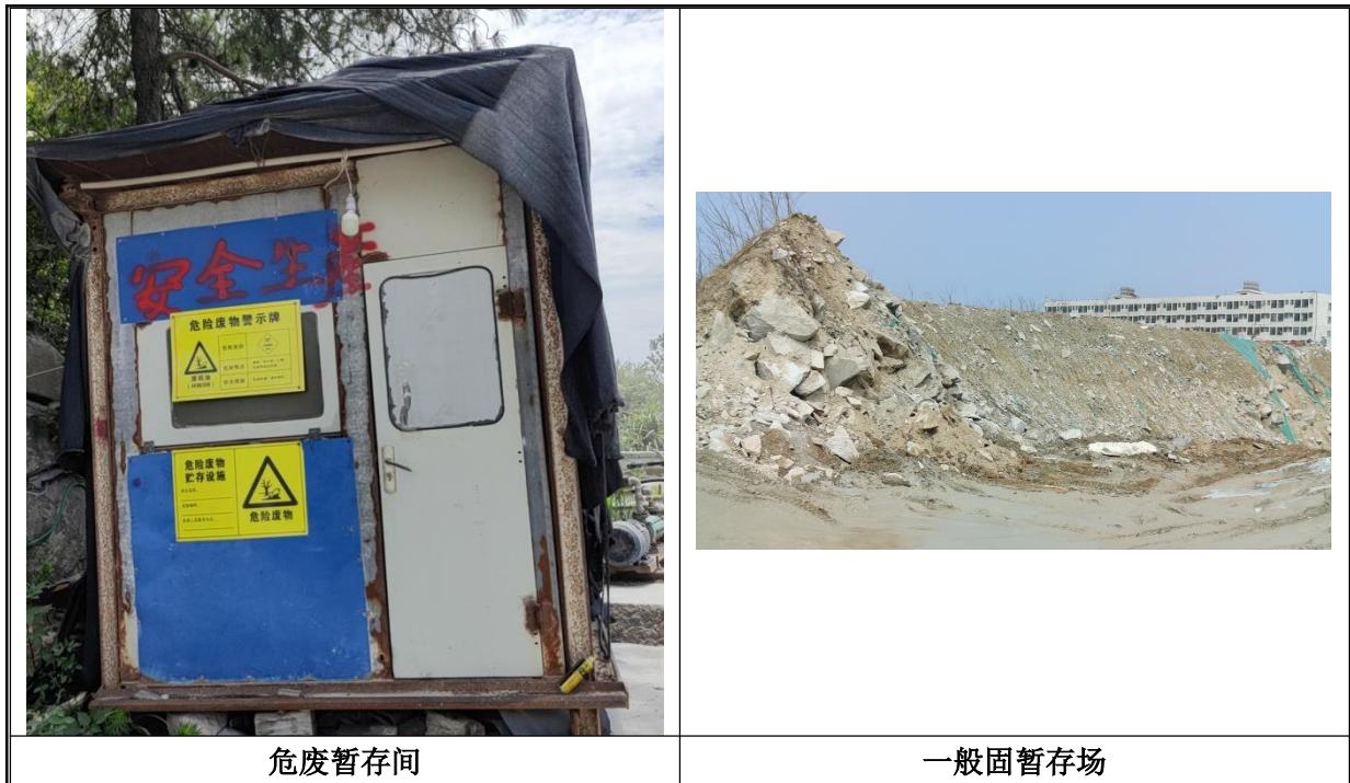
图4-16 项目运营期固废处置措施图
