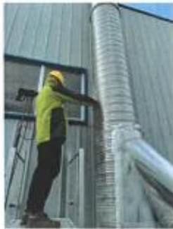
固化喷粉废气排放口
